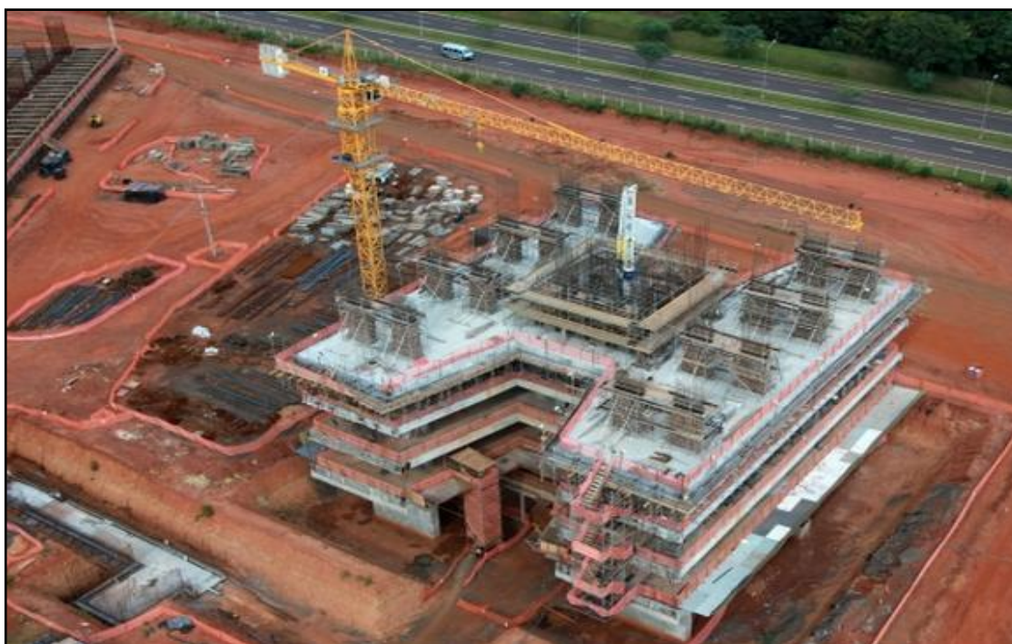
Foto 14 – Obras do futuro campus da UNILA, dentro da área de Itaipu. Fonte: UNILA, 2013.
